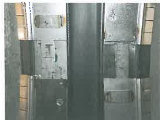
Bild 4: Schlösser der Spannrings im eingebauten Zustand
